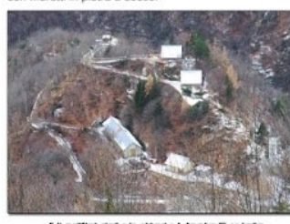
Gli edifici della batteria Monte Castello
